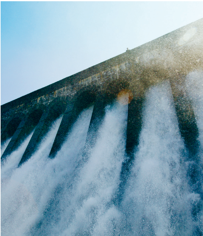
Hochwasserüberlauf der Möhnetalsperre
