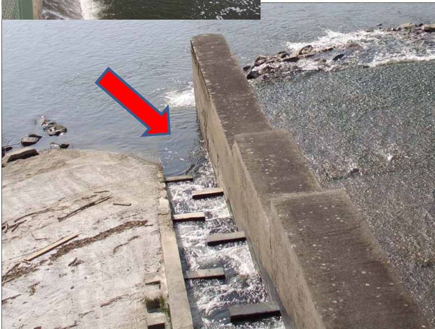
Fischtreppe an einem Wasserkraftwerk (Main)
