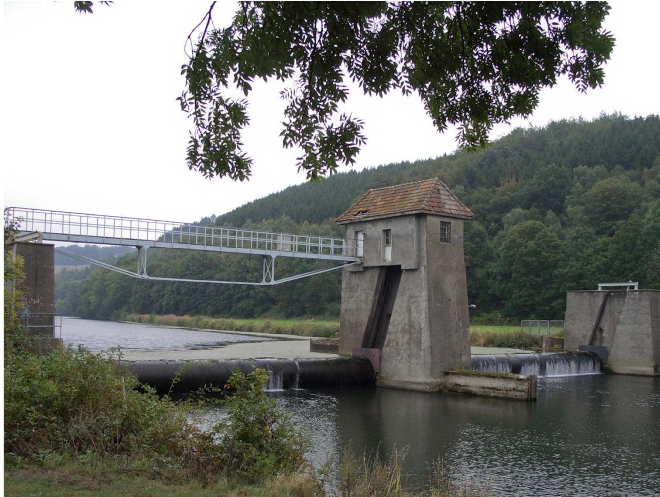
Wehranlage an der Ruhr
