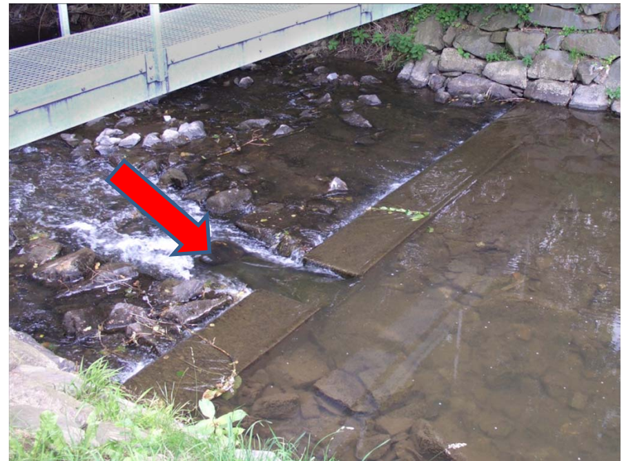
Fischpass durch Rückbau eines Querbauwerks (Felderbach, Essen)
