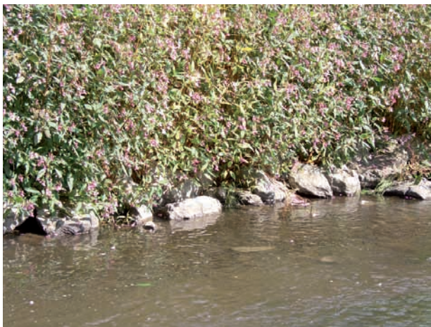
Abb. 20: Steinschüttung im Uferbereich zur Befestigung
